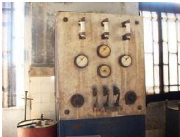
Figura 27. Quadro Elétrico de manobra da central elétrica
